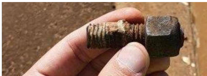
Ilustración 7 - Falla general de tornillo de sujeción
