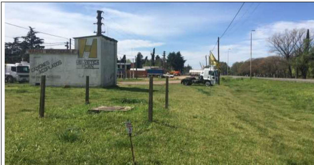
Edificación perteneciente a la red de agua potable, Prog. 264+300, mano ascendente
