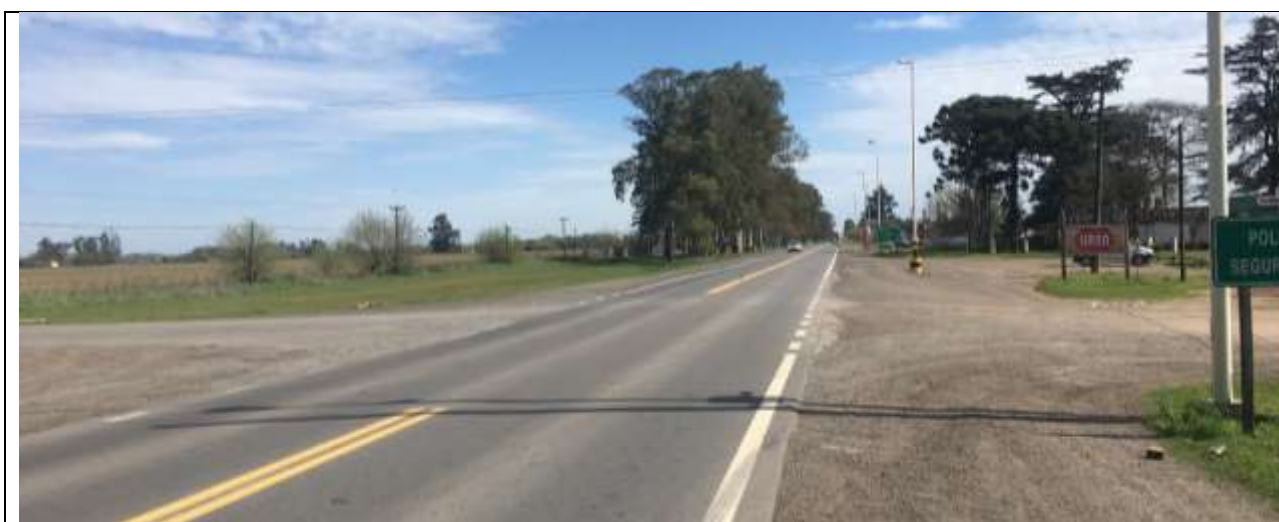
Progresiva 264+800. Rotonda RN N°5 y Gral. Madariaga, vista hacia el sudoeste
