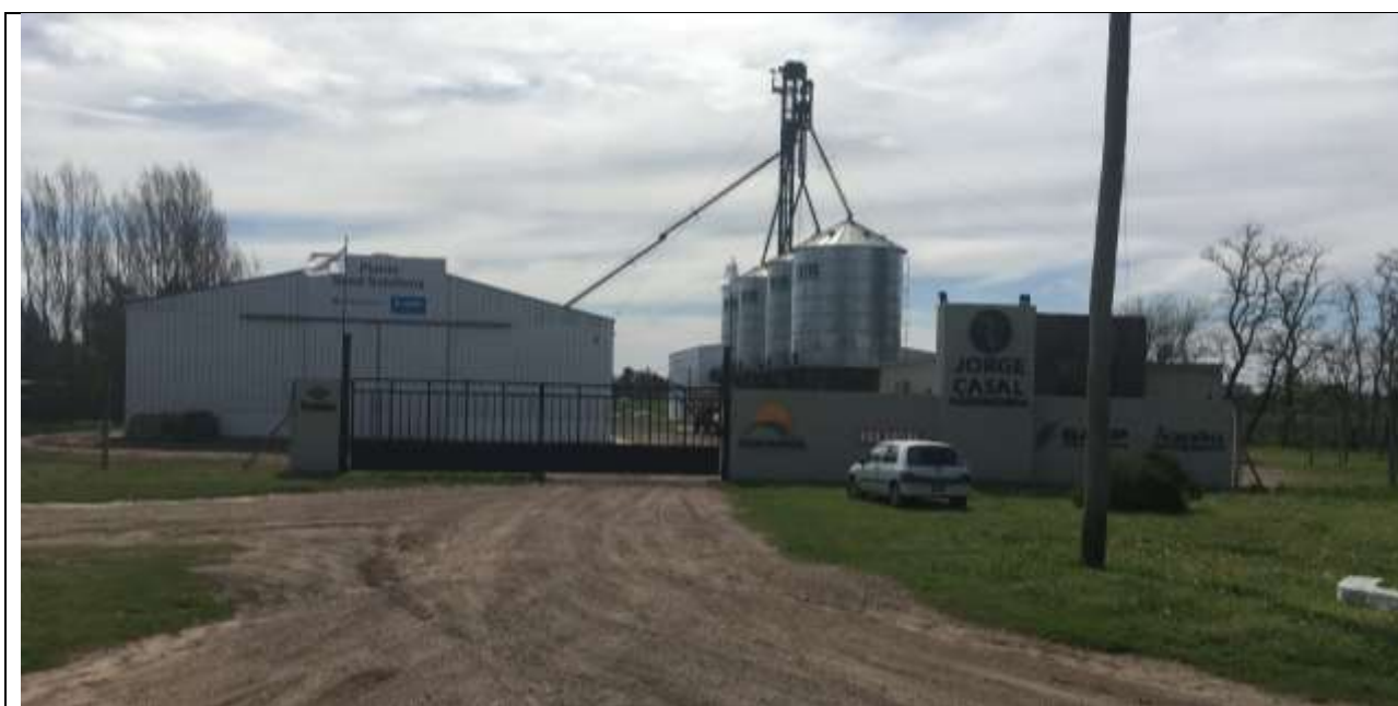
Mano ascendente, próxima a Progresiva 264+800 (Rotonda RN N°5 y Gral. Madariaga)
