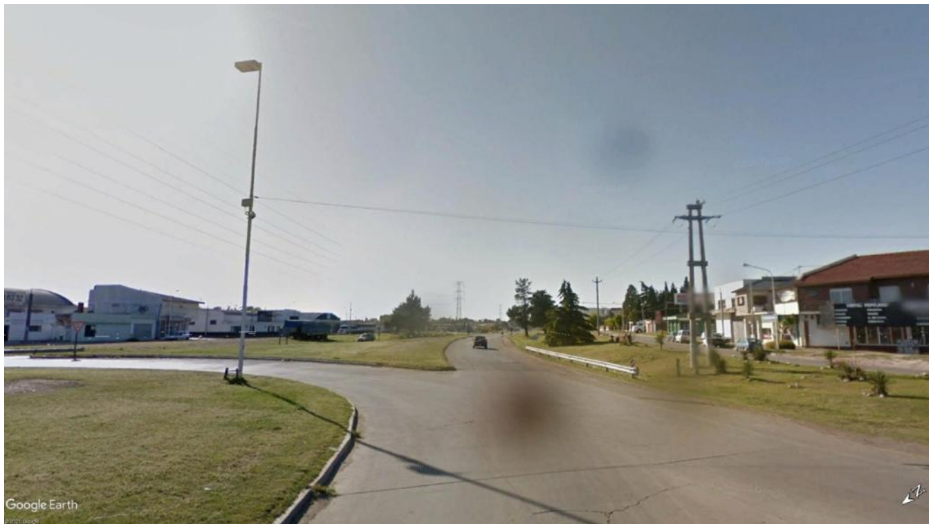
Imagen 3.7 – Vista de isletas, calzada anular y rama de salida descendente – Reubicación de columna y retiro de baranda metálica.
