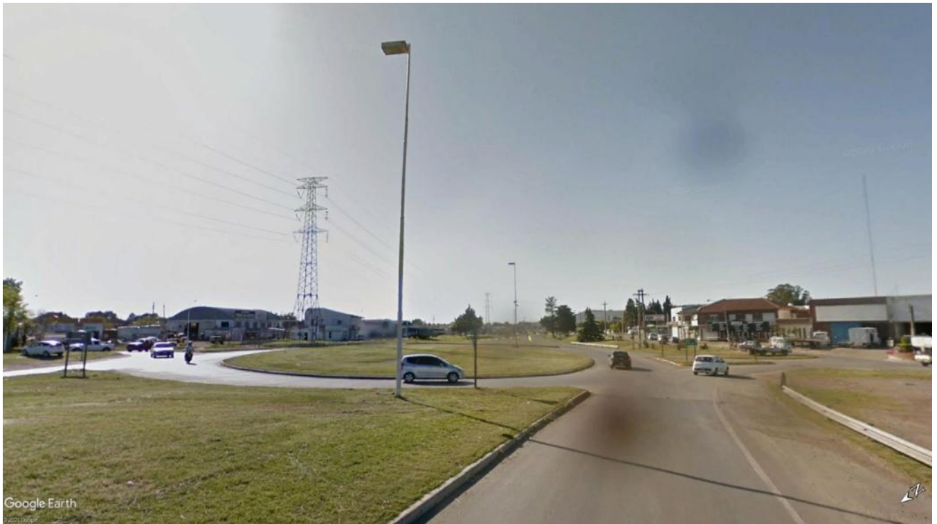
Imagen 3.5 – Vista de ingreso a Rotonda por Lado Desc. – Reubicación de luminaria
